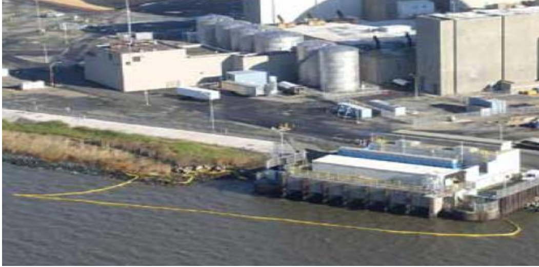
الشكل رقم (٦): حاجز تم وضعه لحماية أمام مأخذ/مدخل مياه التبريد لمحطة توليد الطاقة.
